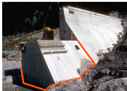
FIGURE 1 – Exemple d'interface béton – rocher.
